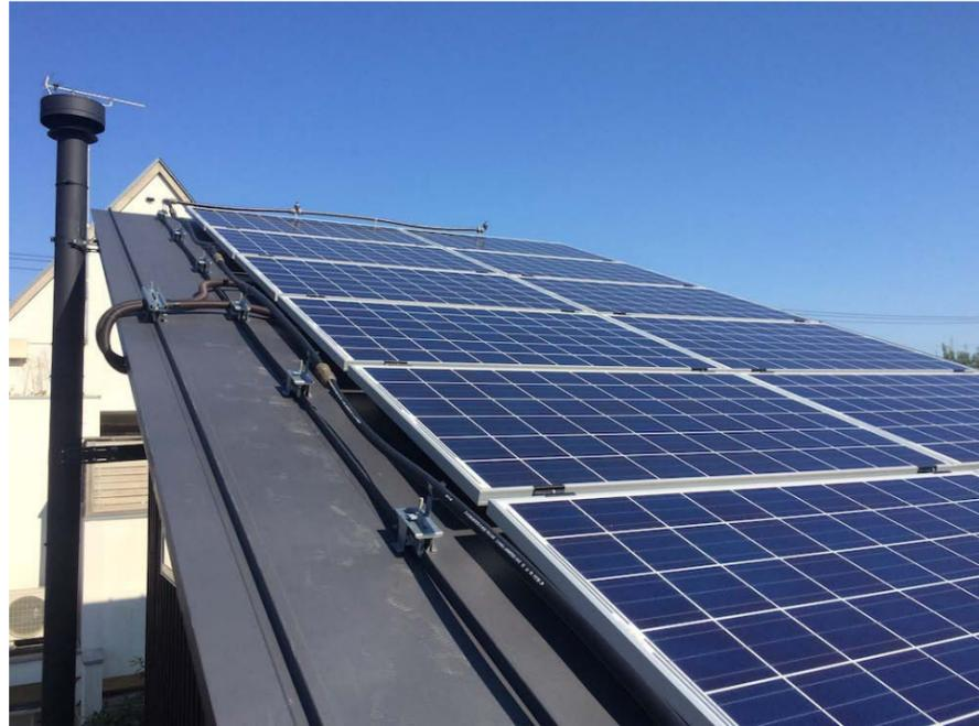
太陽光発電モジュール [Qセルズ] 275W×12枚=3.3kW
